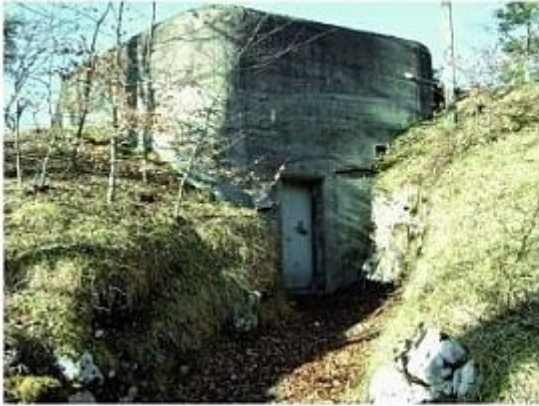
Mg-Bunker, A 3485 Challplatten-Nord
