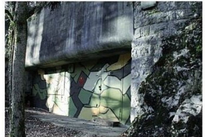
Bunker Nord, A 3491 Panzersperre Kleinlützel / SO
