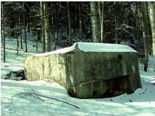
Lmg-Bunker, A 3496 Räschberg-Ost
