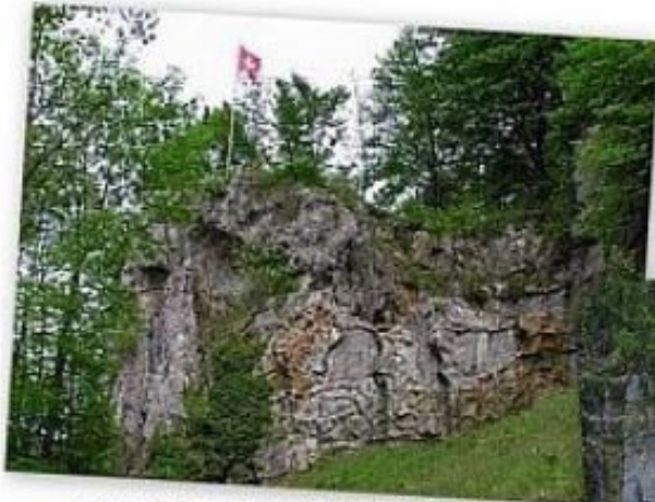
A 3492 Bunker Süd Kleinlützel
